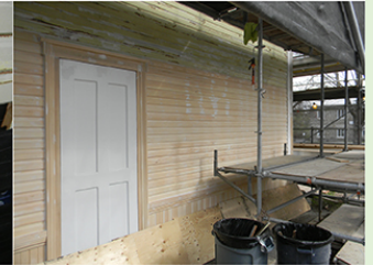
False door replacement
